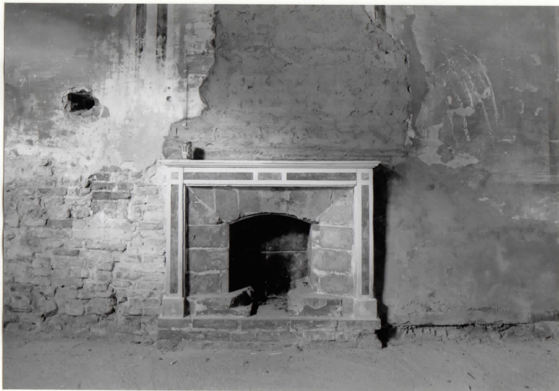
CATTINO AL PIANO TERRA
