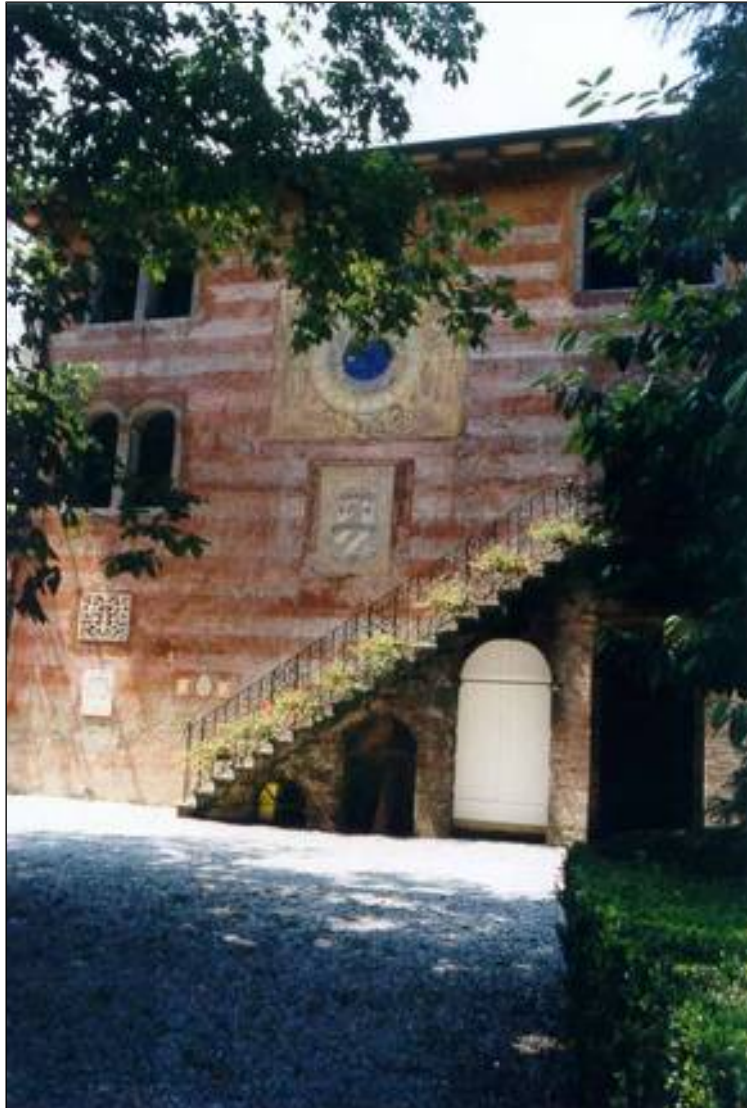
Prospetto est della Cantina di villa della Zonca (neg. n°67981).
