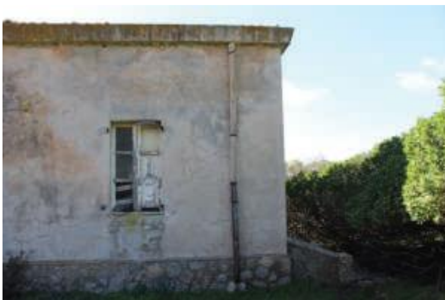
Immobile denominato "Ex Ufficio Postale" a Cala Reale nell'Isola dell'Asinara: prospetto posteriore, corpo aggiunto
