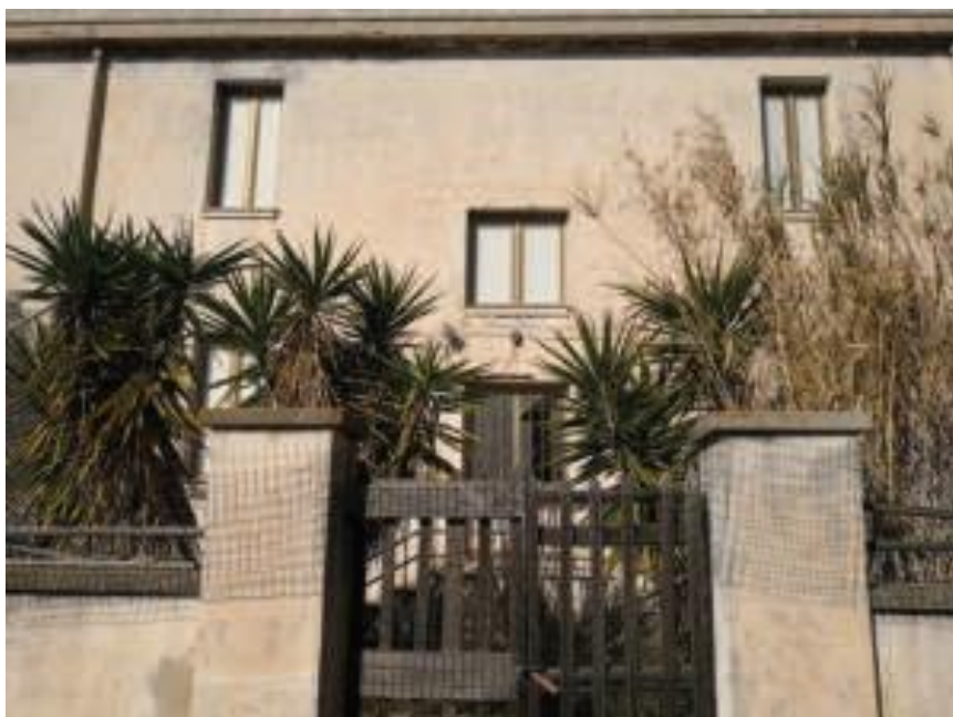
Immobile denominato “Palazzina Direttore” a Cala Reale nell’Isola dell’Asinara: dettaglio facciata principale sul fronte strada (lato cortile antistante)
