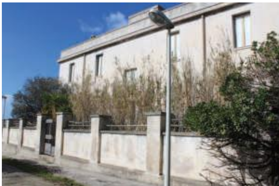
Immobile denominato “Palazzina Direttore” a Cala Reale nell’Isola dell’Asinara: fronte sul lato strada
