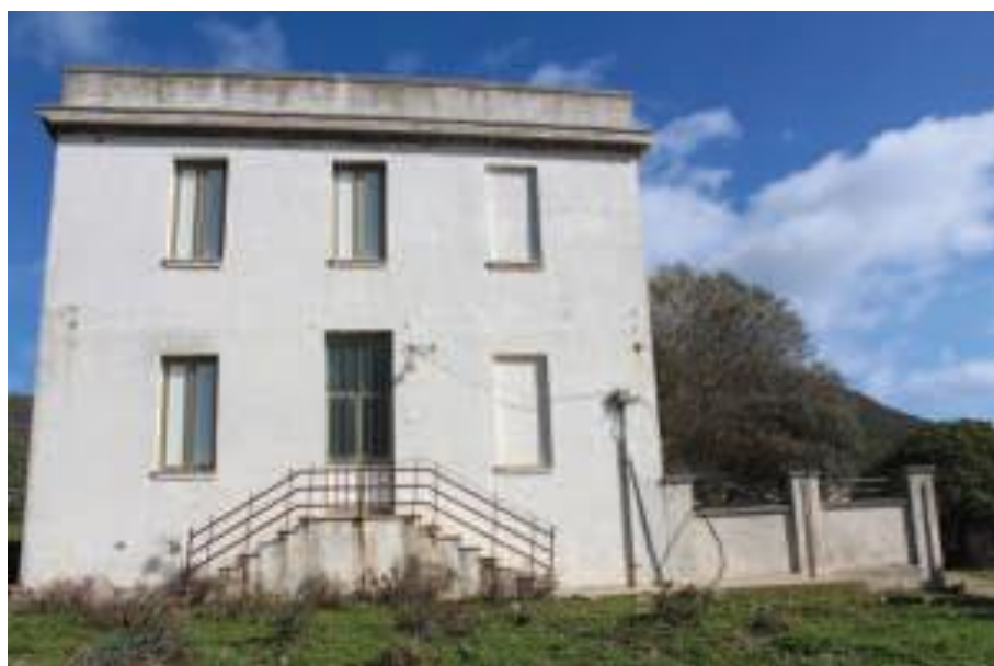
Immobile denominato “Palazzina Direttore” a Cala Reale nell’Isola dell’Asinara: fronte sul lato interno (accesso indipendente due alloggi)
