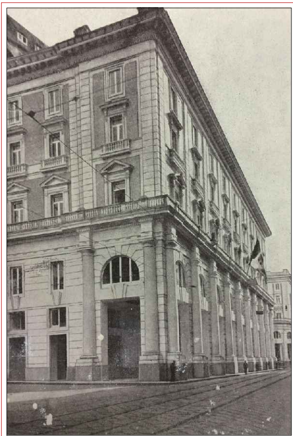
foto 1 - La ricostruzione del primo fabbricato col porticato per facilitare la viabilità
