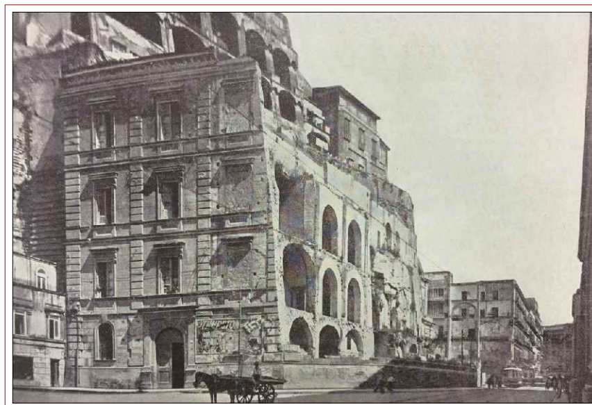
foto 2 - Stato delle fabbriche ex Demaniali demolite nel 1928 per la costruzione della Galleria Veduta dalla piazza Domenico Morelli
