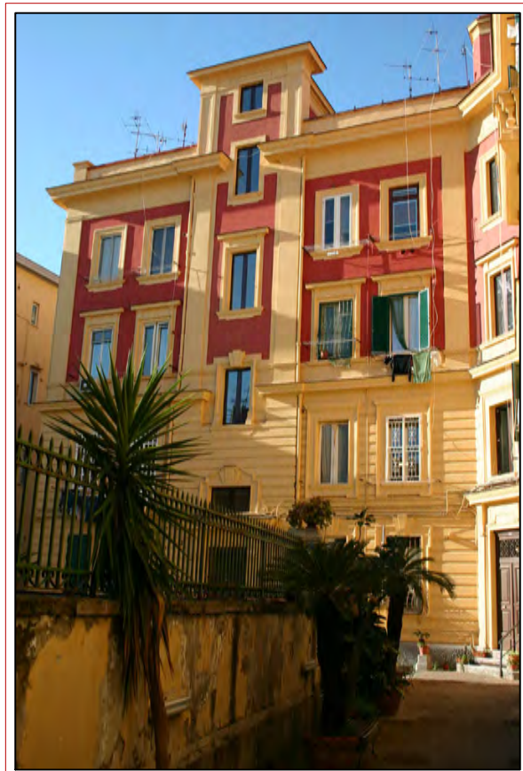
foto 5-PROSPETTO NORD-EST CORTILE INTERNO
