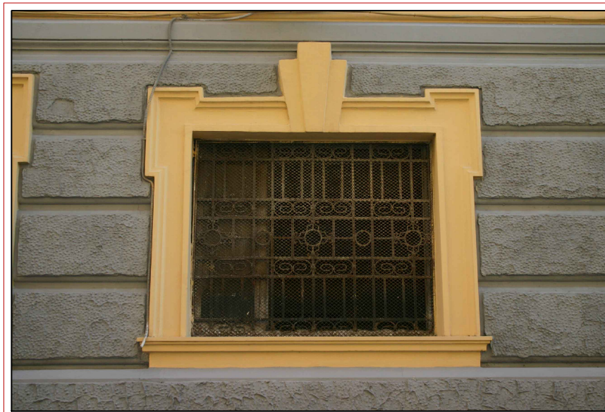
foto 10-CORNICE LUCERNAIO PIANO CANTINATO SU VIA S.CATERINA
