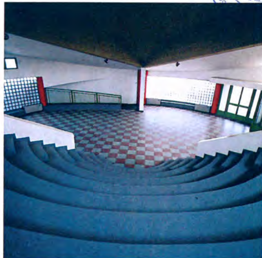
L'edificio allo stato attuale (esterno) Il teatrino del livello superiore (interno)
