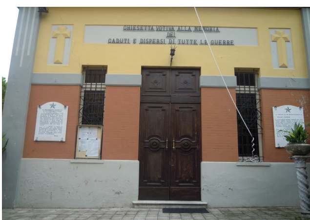
Ingresso della Chiesa dedicata ai caduti e ai dispersi di tutte le guerre (sopralluogo settembre 2011)
