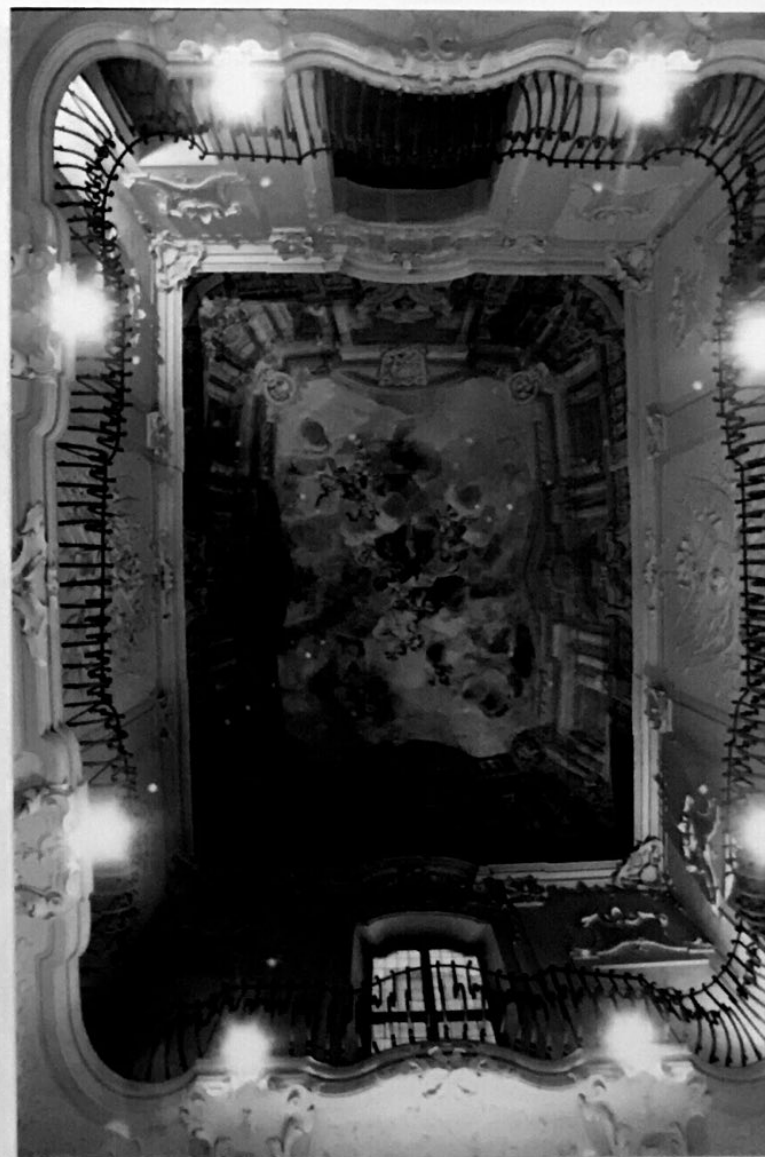
SALONE AL PIANO NOBILE - PARTICOLARE DEL SOFFITO
