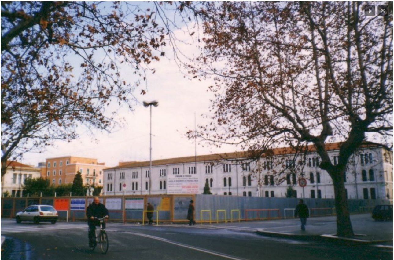
Dicembre 1997 – Lavori di ristrutturazione di Piazza Italia
