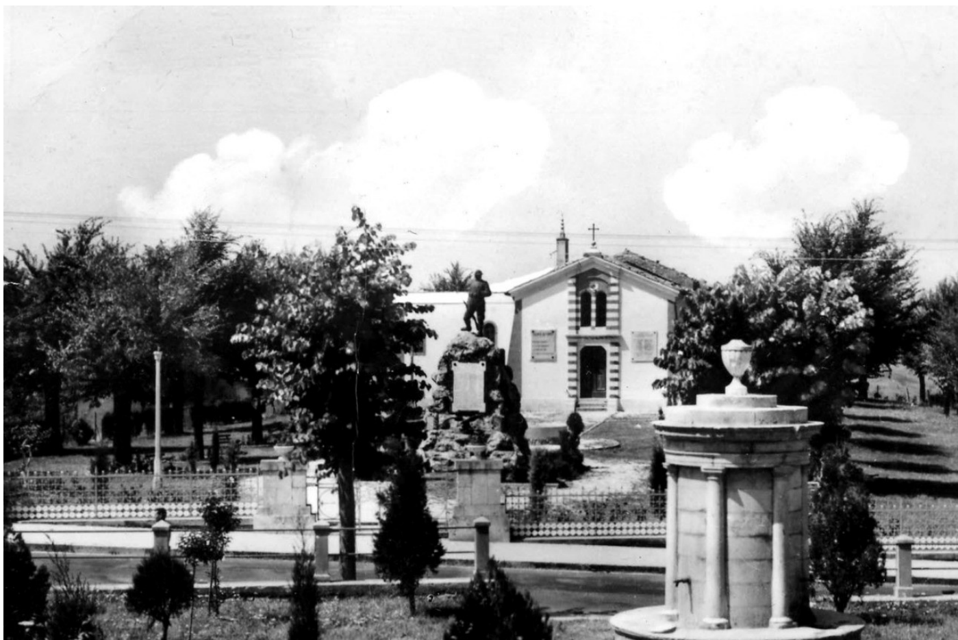
Parco della Rimembranza prima della demolizione della Chiesa di S.Vito (Archivio arch. Del Grosso)
