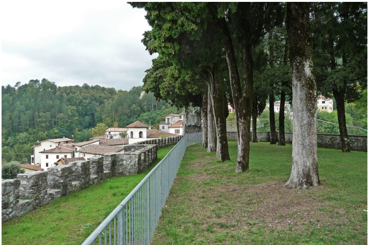
Foto n°7: vista in direzione delle merlature
