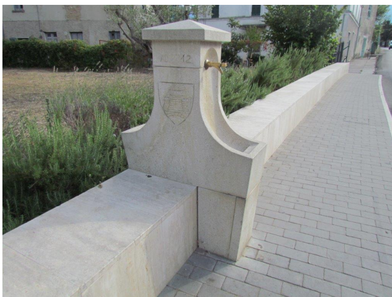
particolare della recinzione
