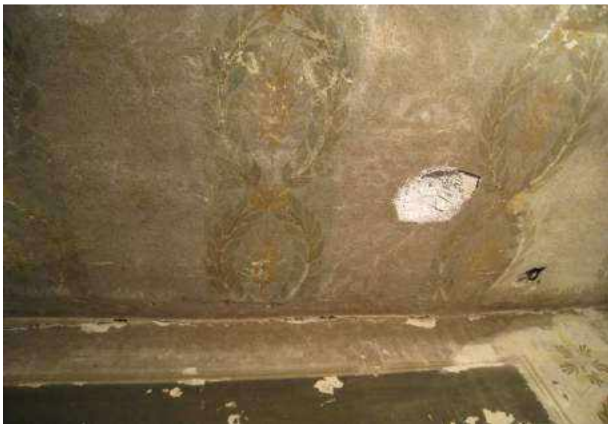
Figg. 30 e 31: Palazzolo sull'Oglio, Salone al secondo piano del Municipio, particolari del soffitto prima del restauro: sollevamenti della pellicola pittorica e aloni di umidità
