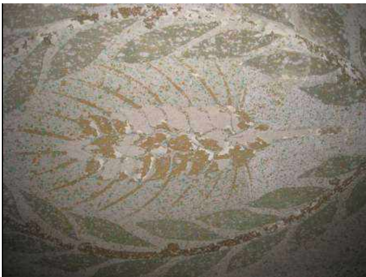
Figg. 28 e 29: Palazzolo sull'Oglio, Salone al secondo piano del Municipio, particolari del soffitto prima del restauro: sollevamenti e graffi della pellicola pittorica
