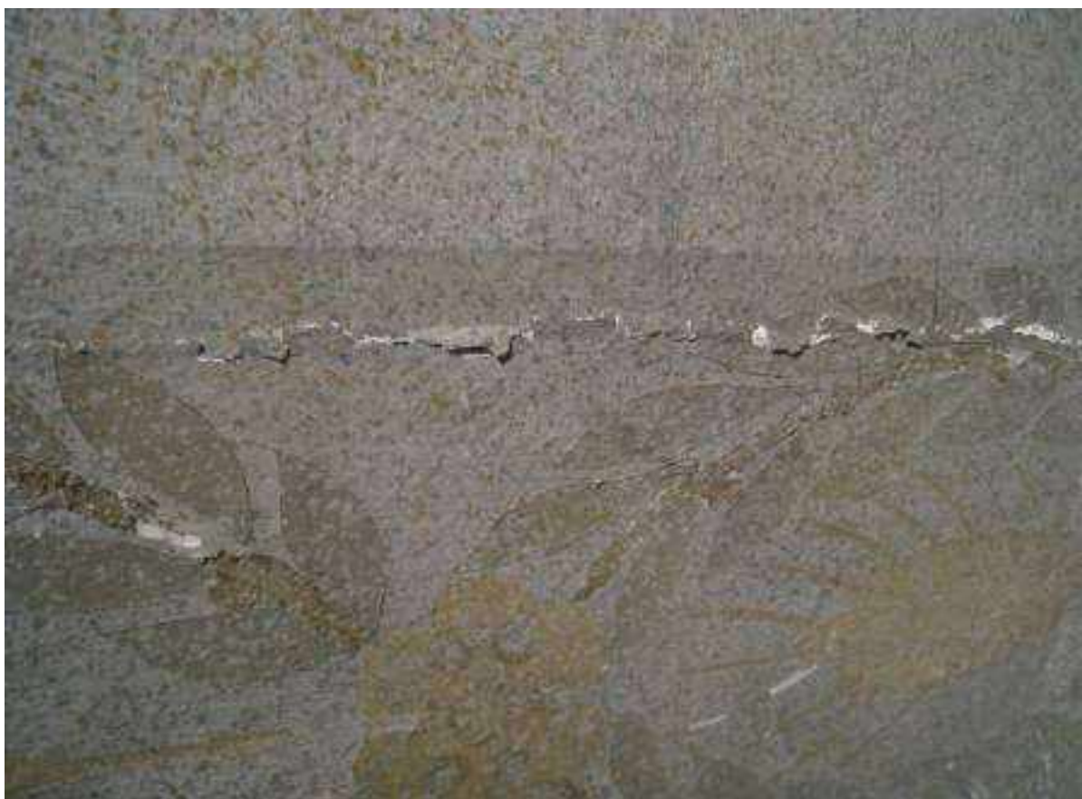
Figg. 19 e 20: Palazzolo sull'Oglio, Salone al secondo piano del Municipio, particolari del soffitto prima del restauro: fessure e crepe
