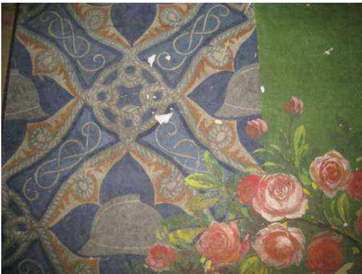
Figg. 38 e 39: Palazzolo sull'Oglio, Salone al secondo piano del Municipio, particolari della fascia superiore delle pareti prima del restauro: sollevamenti e lacune del colore
