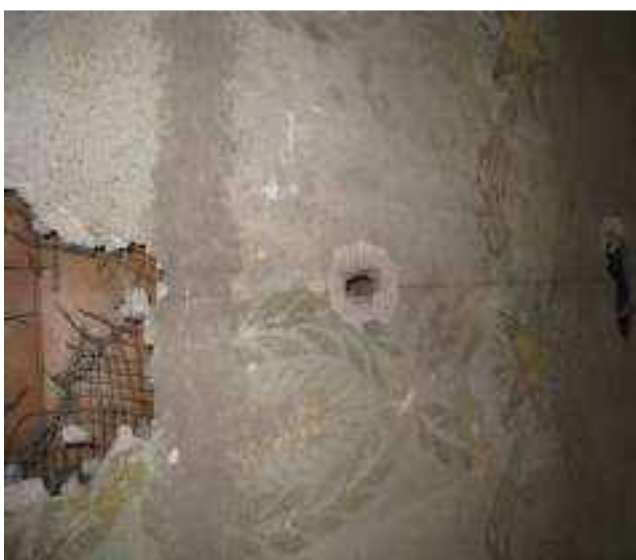
Figg. 16-18: Palazzolo sull'Oglio, Salone al secondo piano del Municipio, particolari del soffitto prima del restauro: fori causati dalla rimozione della controsoffittatura e mancanze d'intonaco
