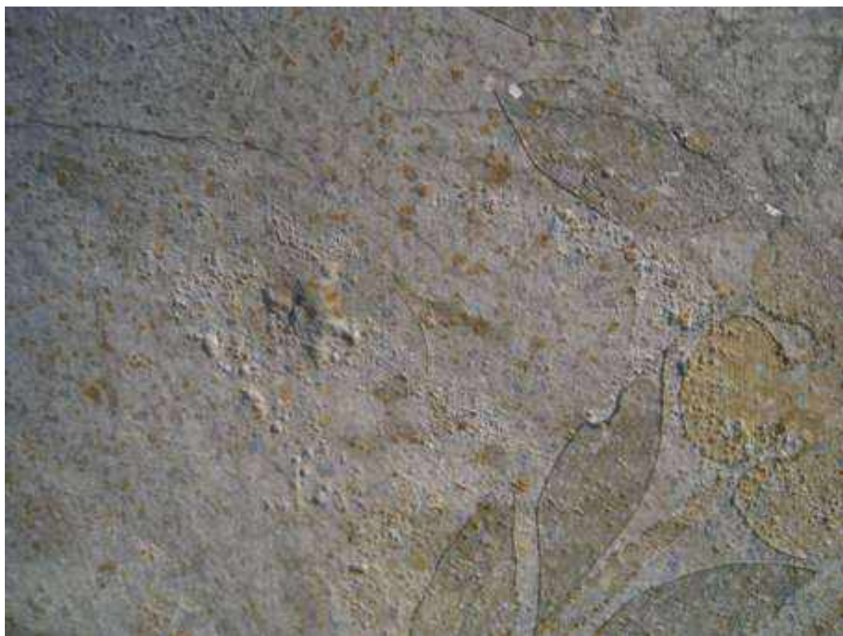
Figg. 22 e 23: Palazzolo sull'Oglio, Salone al secondo piano del Municipio, particolari del soffitto prima del restauro: sollevamenti e "sbollature" della pellicola pittorica
