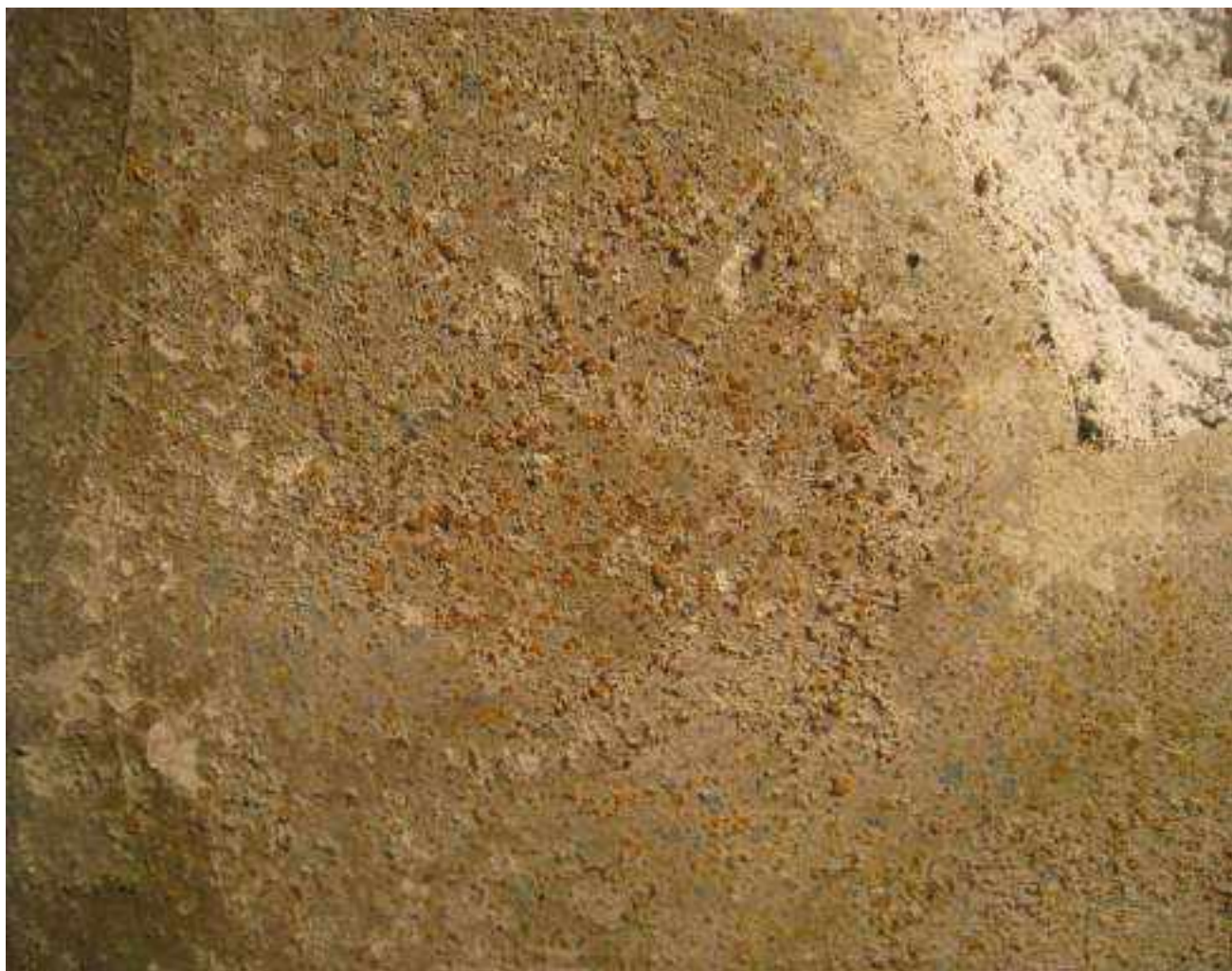
Fig. 21: Palazzolo sull'Oglio, Salone al secondo piano del Municipio, particolare del soffitto prima del restauro: sollevamenti e "sbollature" della pellicola pittorica
