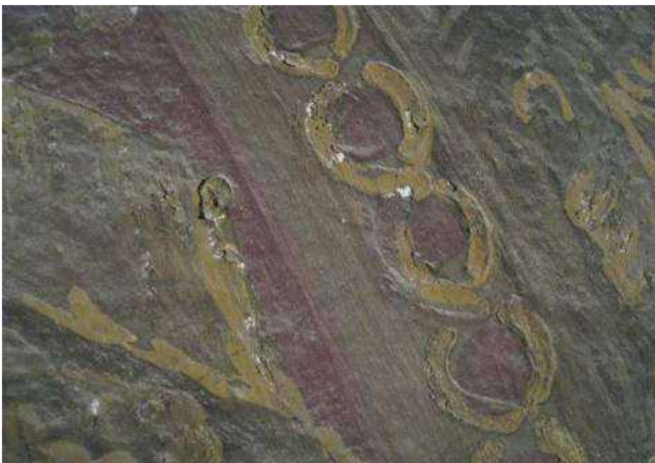
Figg. 35-37: Palazzolo sull'Oglio, Salone al secondo piano del Municipio, particolari della fascia superiore delle pareti prima del restauro: macchie di umidità, fessurazioni e sollevamenti del colore
