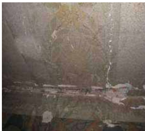
Figg. 16-18: Palazzolo sull'Oglio, Salone al secondo piano del Municipio, particolari del soffitto prima del restauro: fori causati dalla rimozione della controsoffittatura e mancanze d'intonaco
