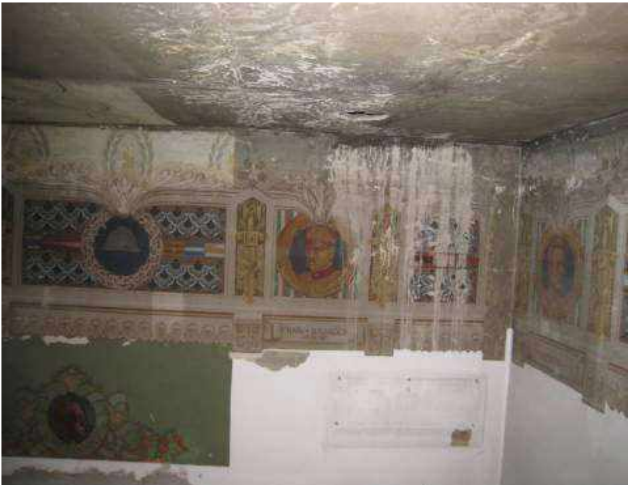
Fig. 32: Palazzolo sull'Oglio, Salone al secondo piano del Municipio, particolari prima del restauro: sollevamenti della pellicola pittorica e aloni di umidità
