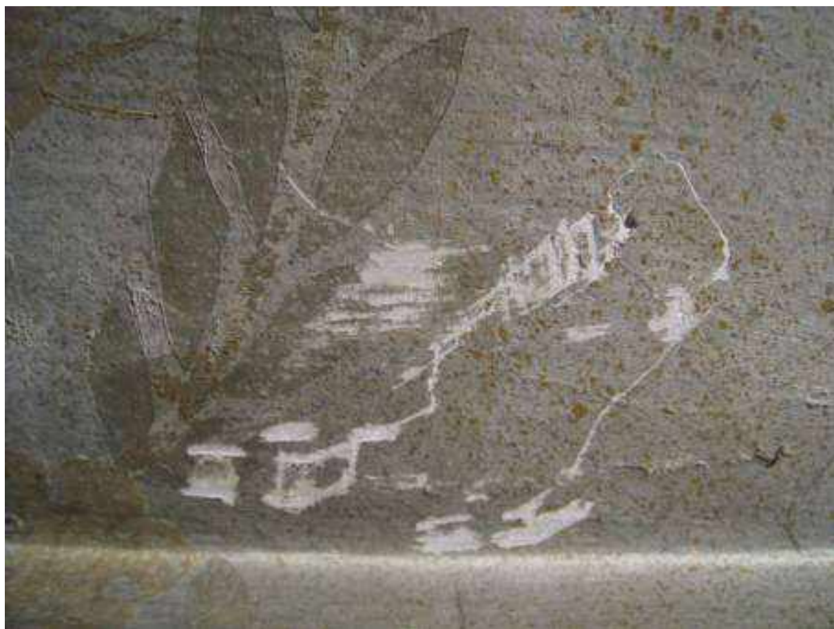
Figg. 26 e 27: Palazzolo sull'Oglio, Salone al secondo piano del Municipio, particolari del soffitto prima del restauro: sollevamenti e graffi della pellicola pittorica
