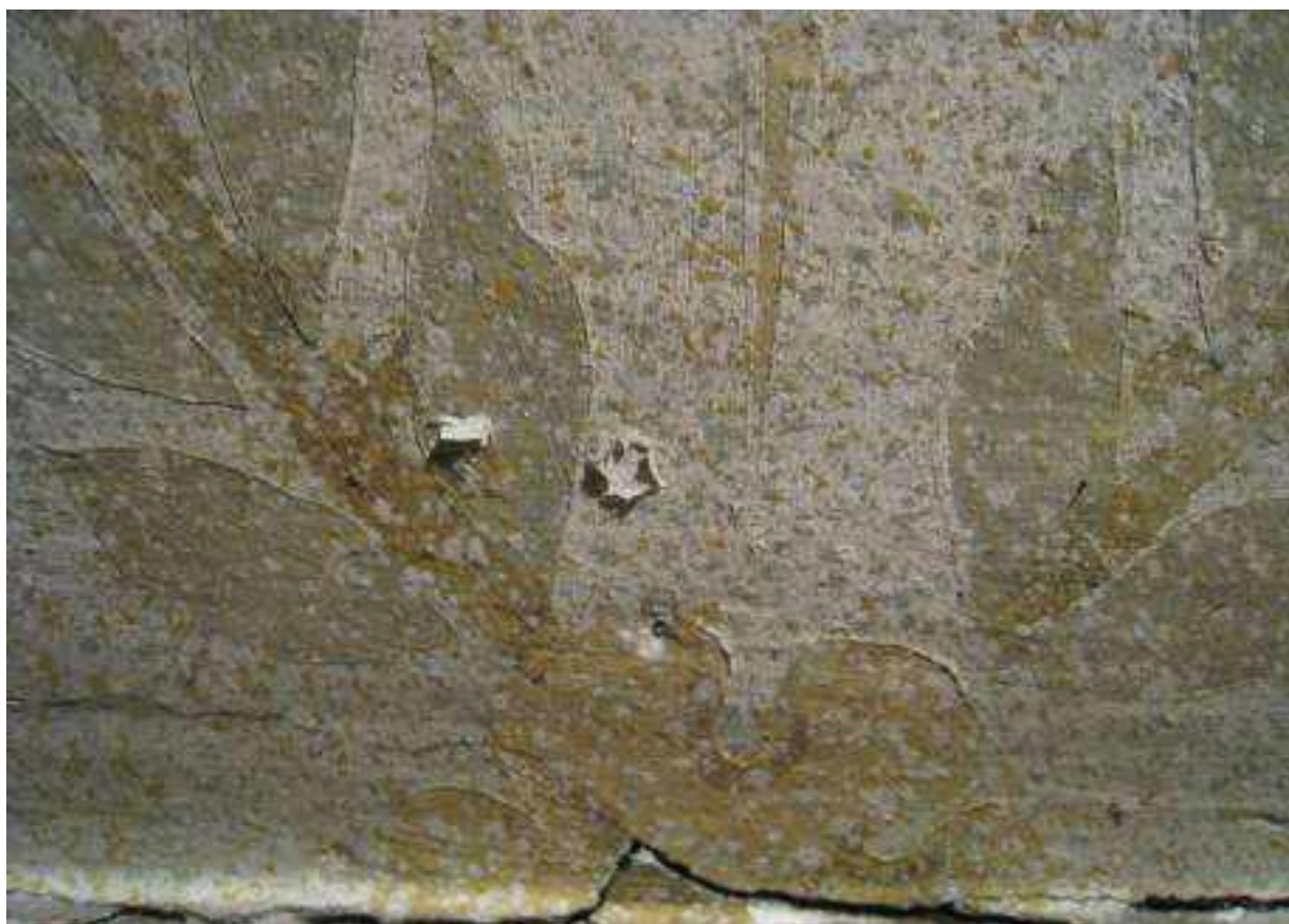
Figg. 24 e 25: Palazzolo sull'Oglio, Salone al secondo piano del Municipio, particolari del soffitto prima del restauro: sollevamenti e "sbollature" della pellicola pittorica
