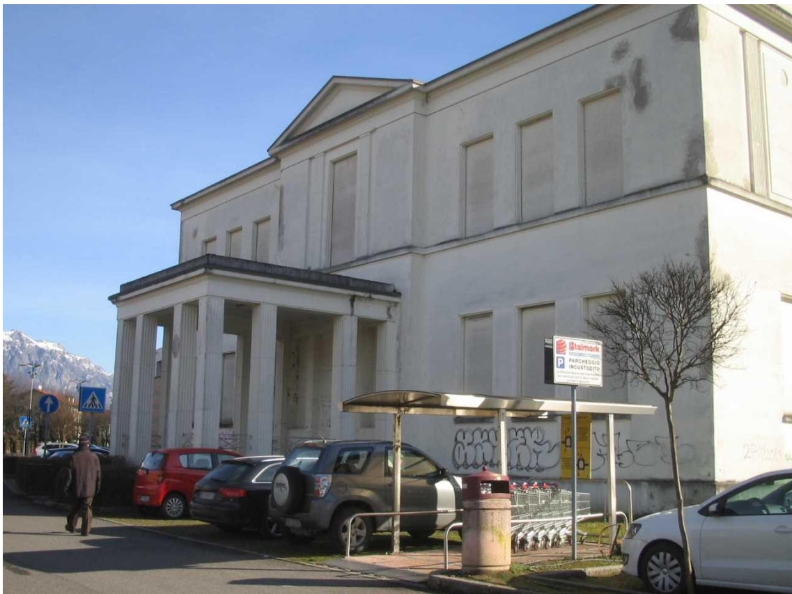
Figura 2. Prospetto Ovest, Ex Scuola Elementare, Pisogne (Brescia). Data: 2/2015. Fonte: VIR Vincoliinrete.
