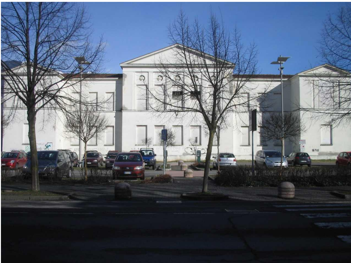
Figura 4. Prospetto Sud, Ex Scuola Elementare, Pisogne (Brescia). Data: 2/2015. Fonte: VIR Vincolinrete.
