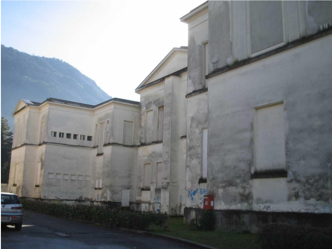
Figura 1. Prospetto Nord, Ex Scuola Elementare, Pisogne (Brescia). Data: 2/2015. Fonte: VIR Vincoliinrete.
