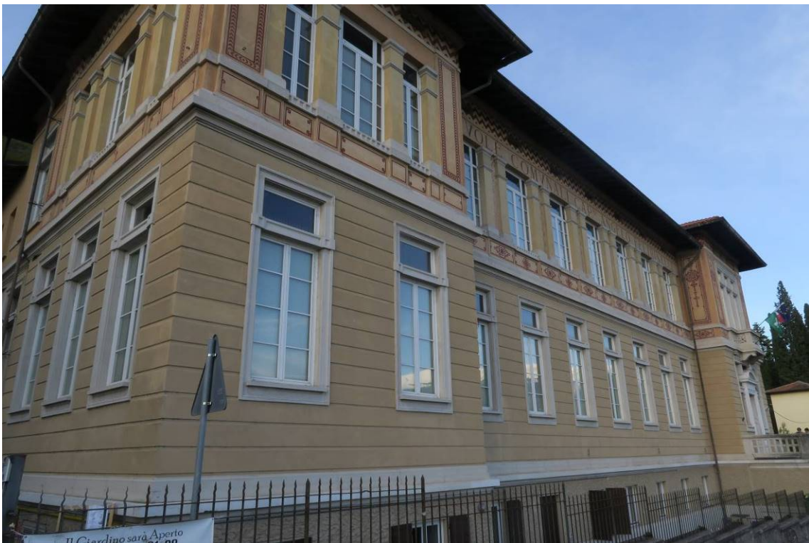
Figura 6. Scuola Feltrinelli, lato Sud-Est. Autore: Braga, Antonio. Data: 2019/11/10.
