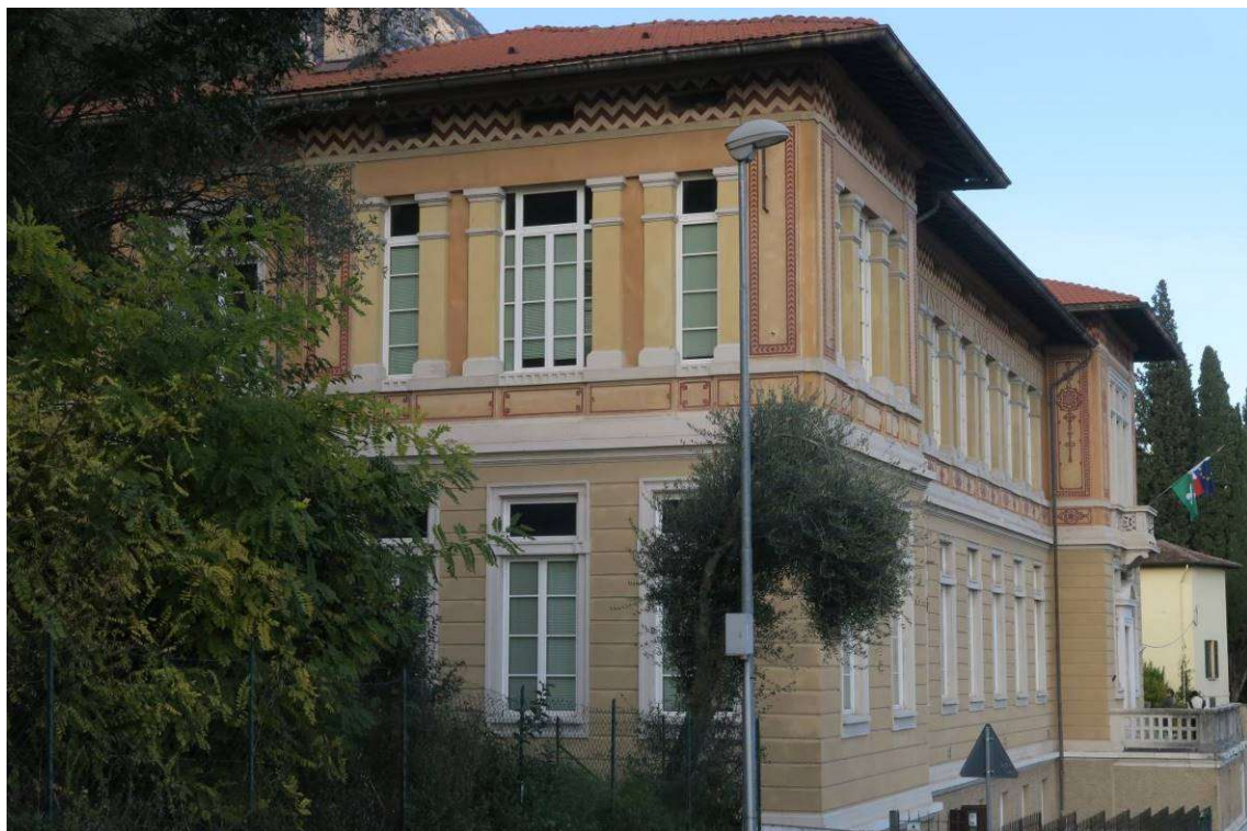
Figura 10. Scuola Feltrinelli, lato Sud-Ovest. Autore: Braga, Antonio. Data: 2019/11/10.
