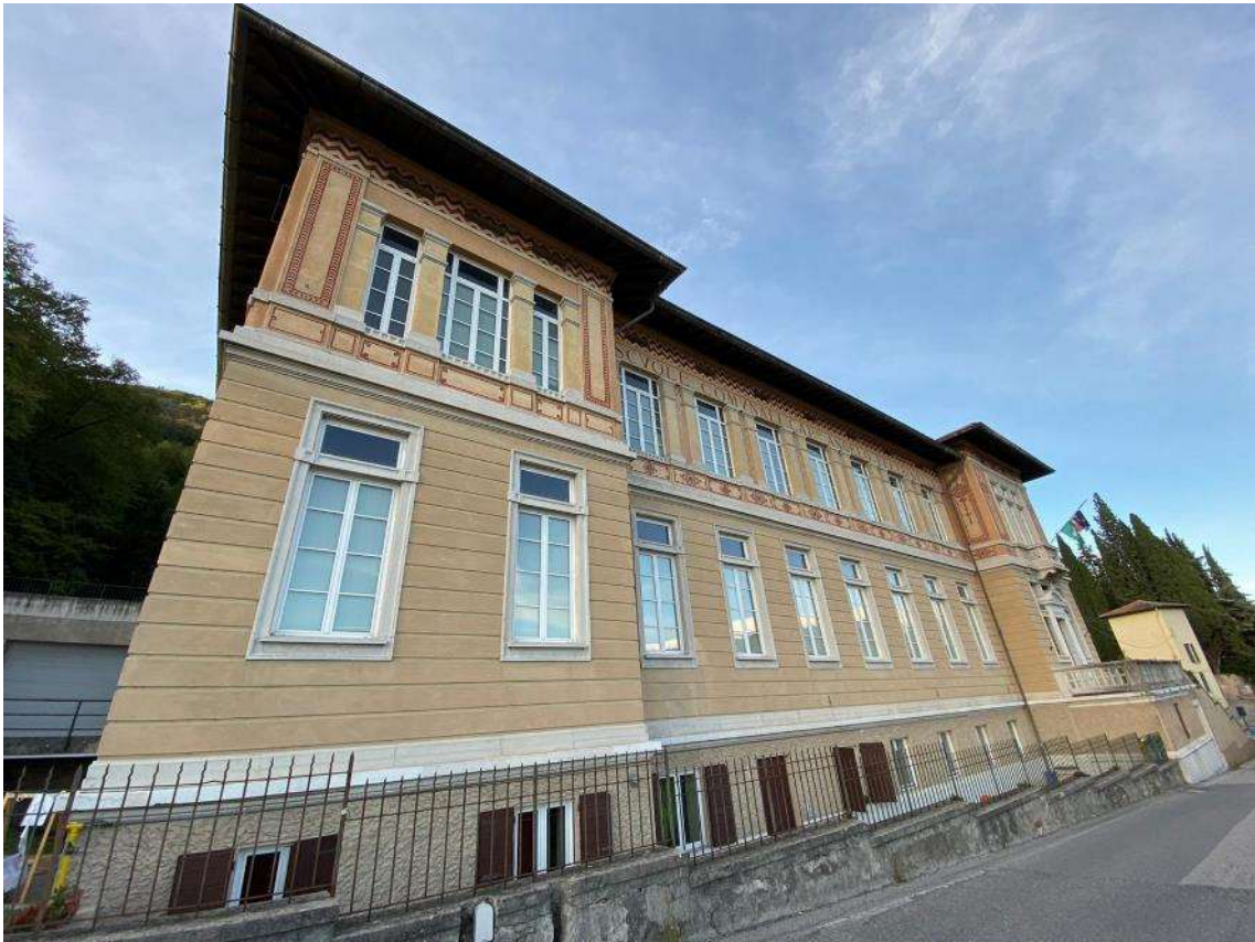
Figura 1. Scuola Feltrinelli, lato Sud-Est. Autore: Scalvini, Maurizio. Data: 2019/11/24.
