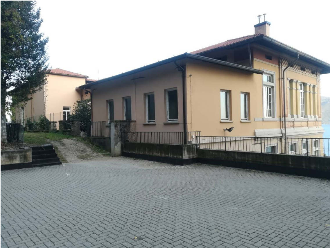
Figura 11. Scuola Feltrinelli, lato Nord-Ovest- Sud-Ovest. Autore: Signorini, Lia. Data: 2019/11/10.
