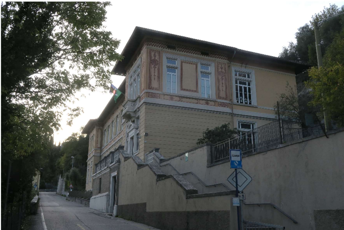
Figura 8 Scuola Feltrinelli, lato Nord-Est. Autore: Braga, Antonio. Data: 2019/11/10.
