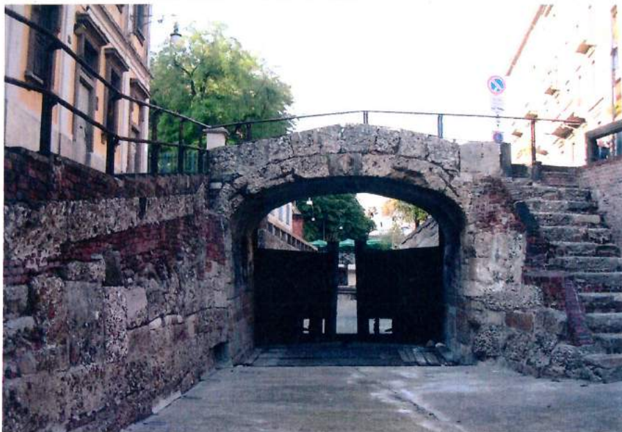
Ponte dell'Incoronata – veduta da sud
