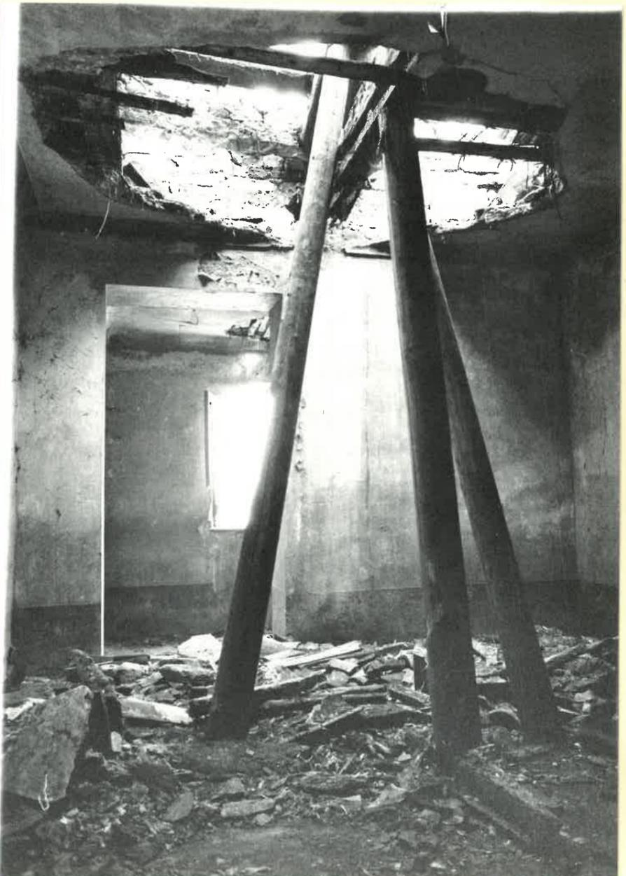
Particolare dello sfondamento del tetto e del crollo del solaio
