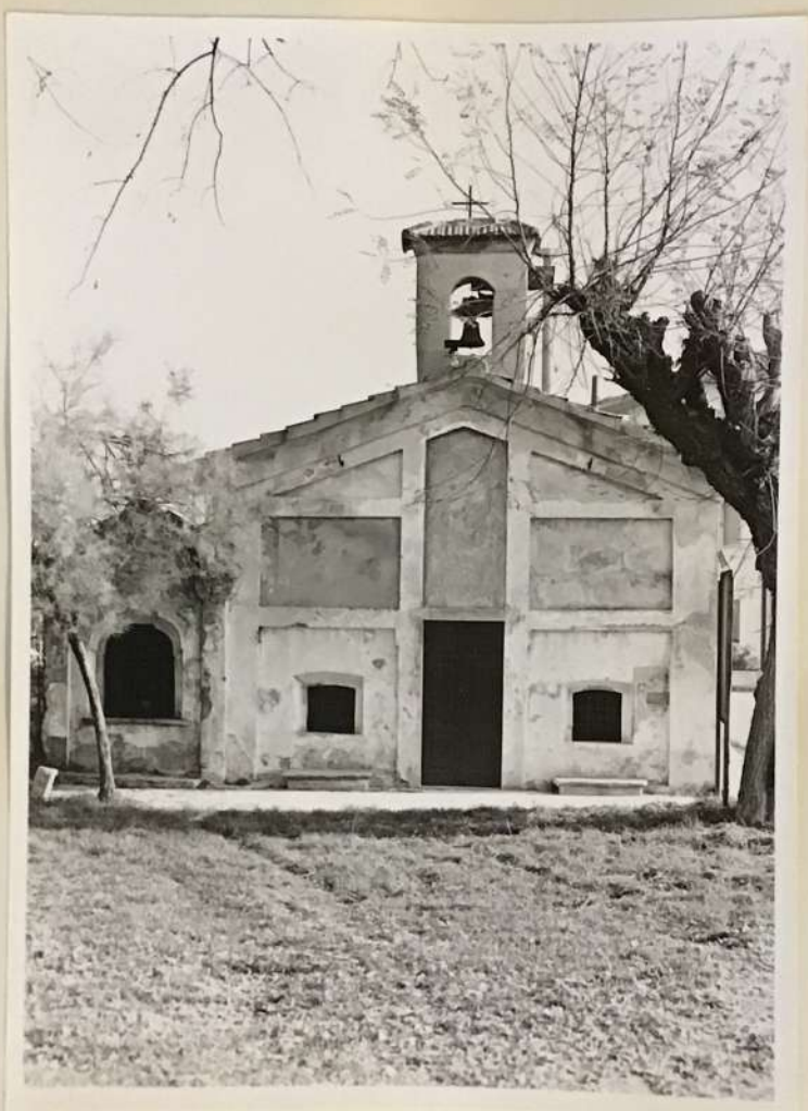
1) facciata, a ovest.
