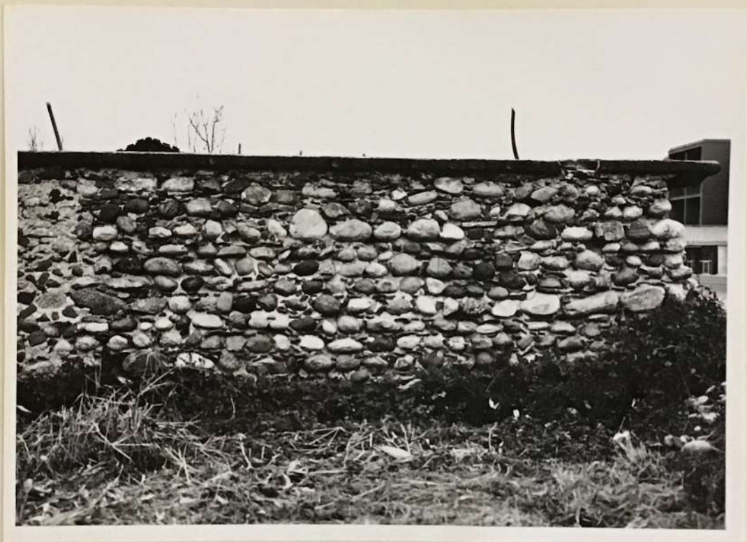
5) particolare del muro di cinta, a ovest.
