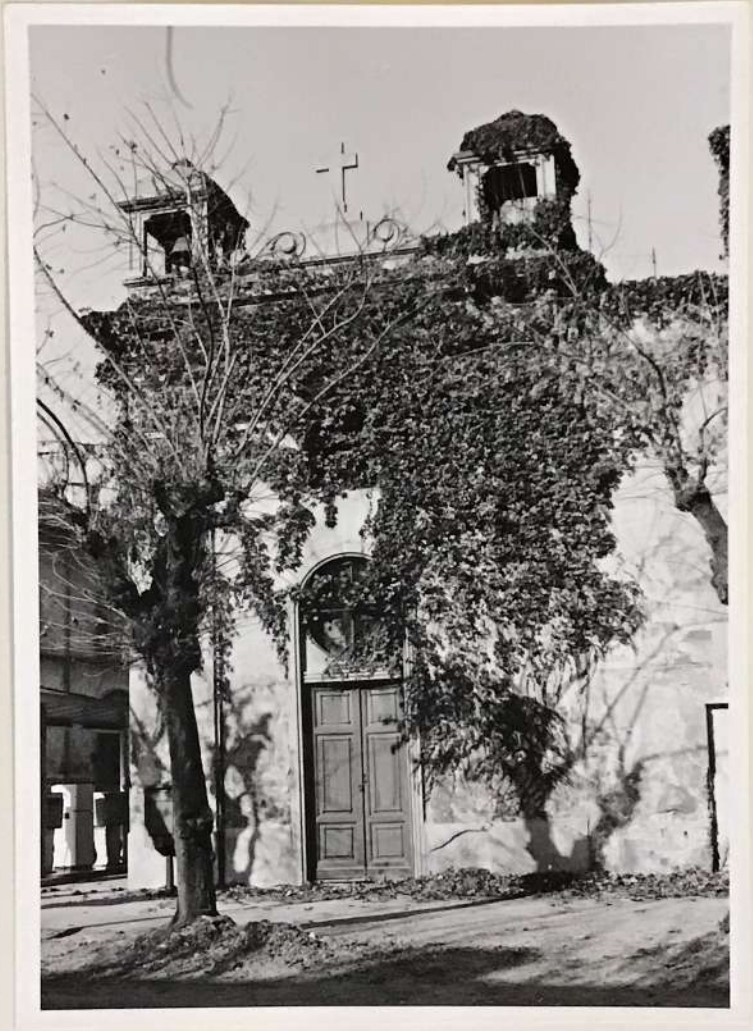
I) facciata, a sud.
