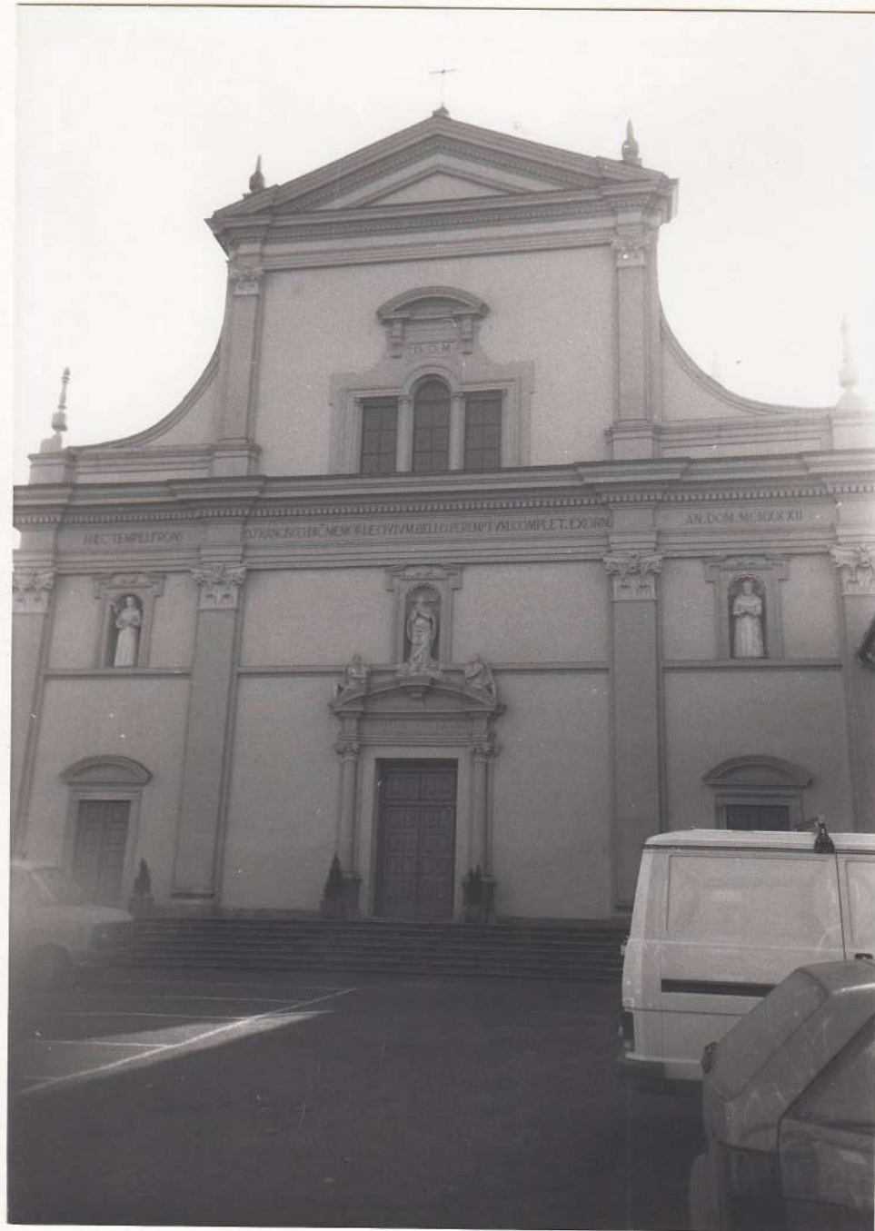
Chiesa di San Francesco: facciata Ovest
