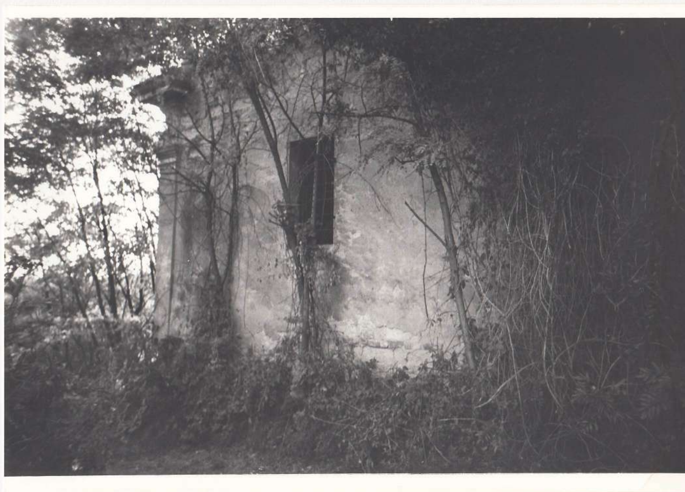
CHIESA DI SAN MARTINO: prospetto Est
