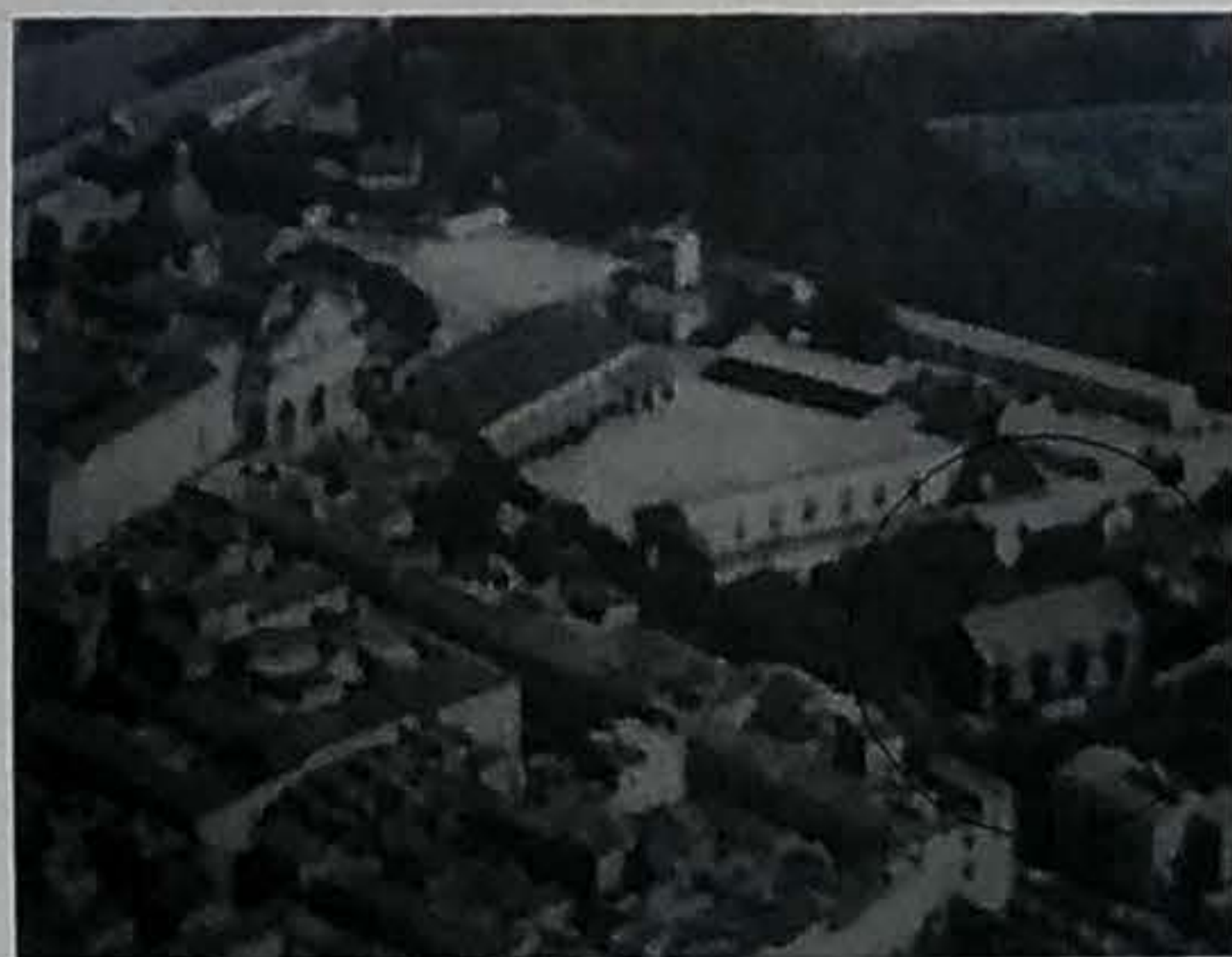
Rilievo grafico e fotografico eseguito dall'arch. Virginia Russo
