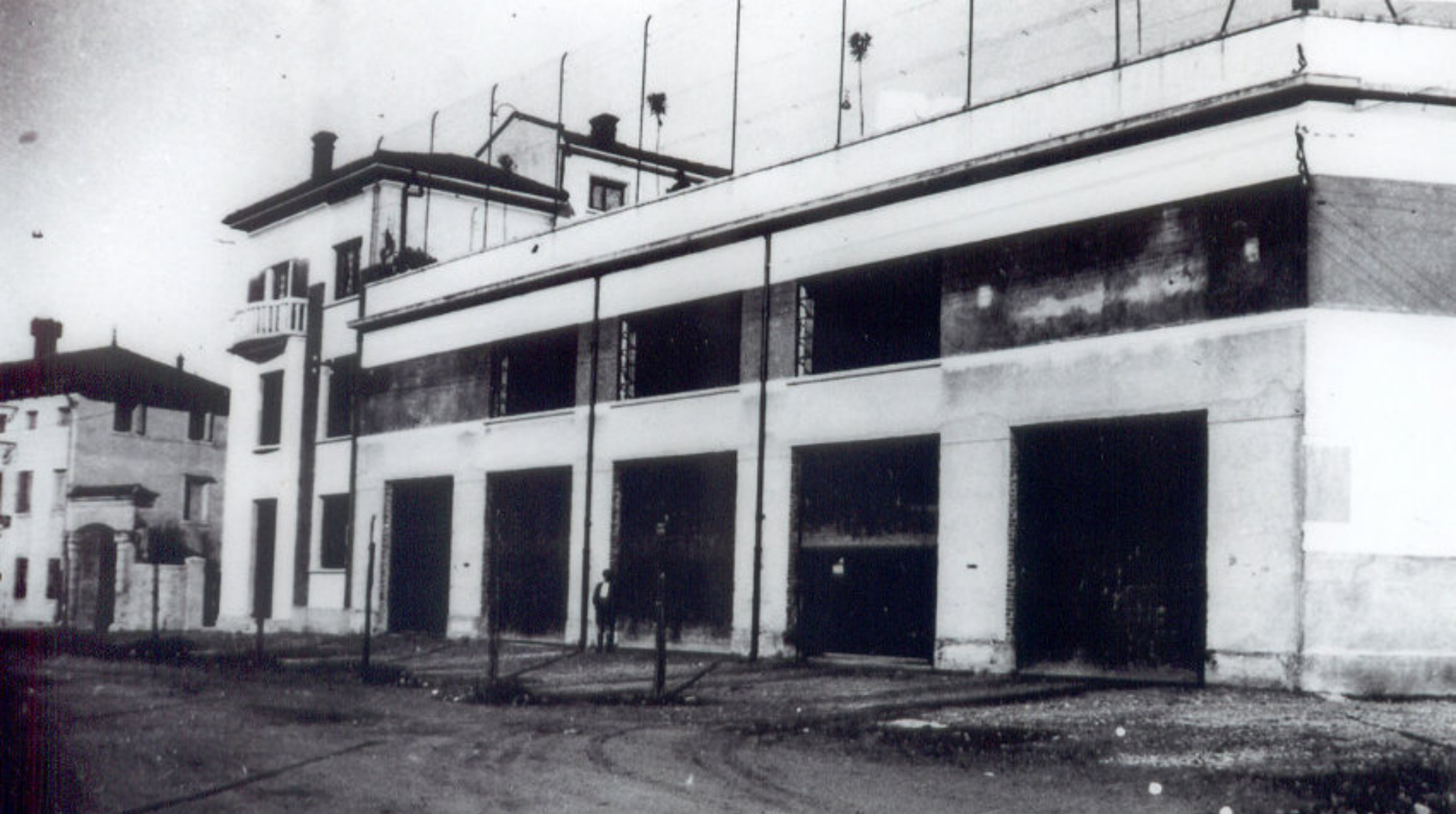
Edificio del Cinema Miotto
