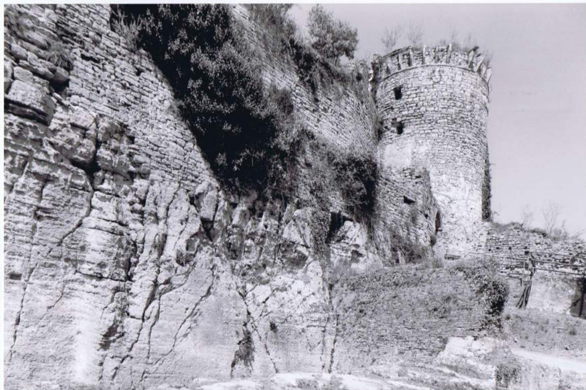
Veduta esterna della torretta
