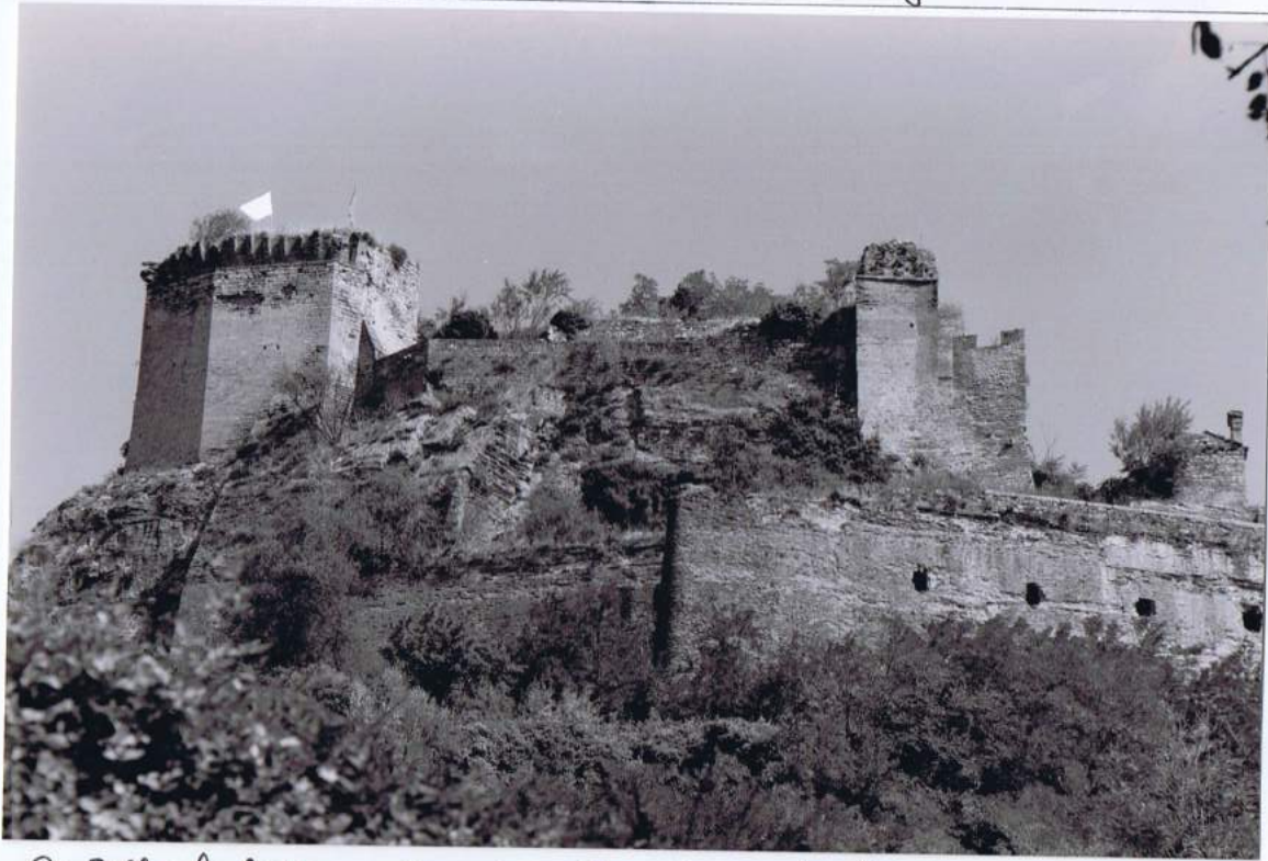
Casello fontana - mura esterne e bastione poligonale
