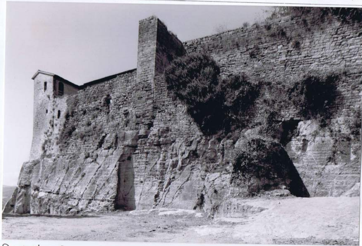
Prospetto esterno delle mura sul fianco di scacco
