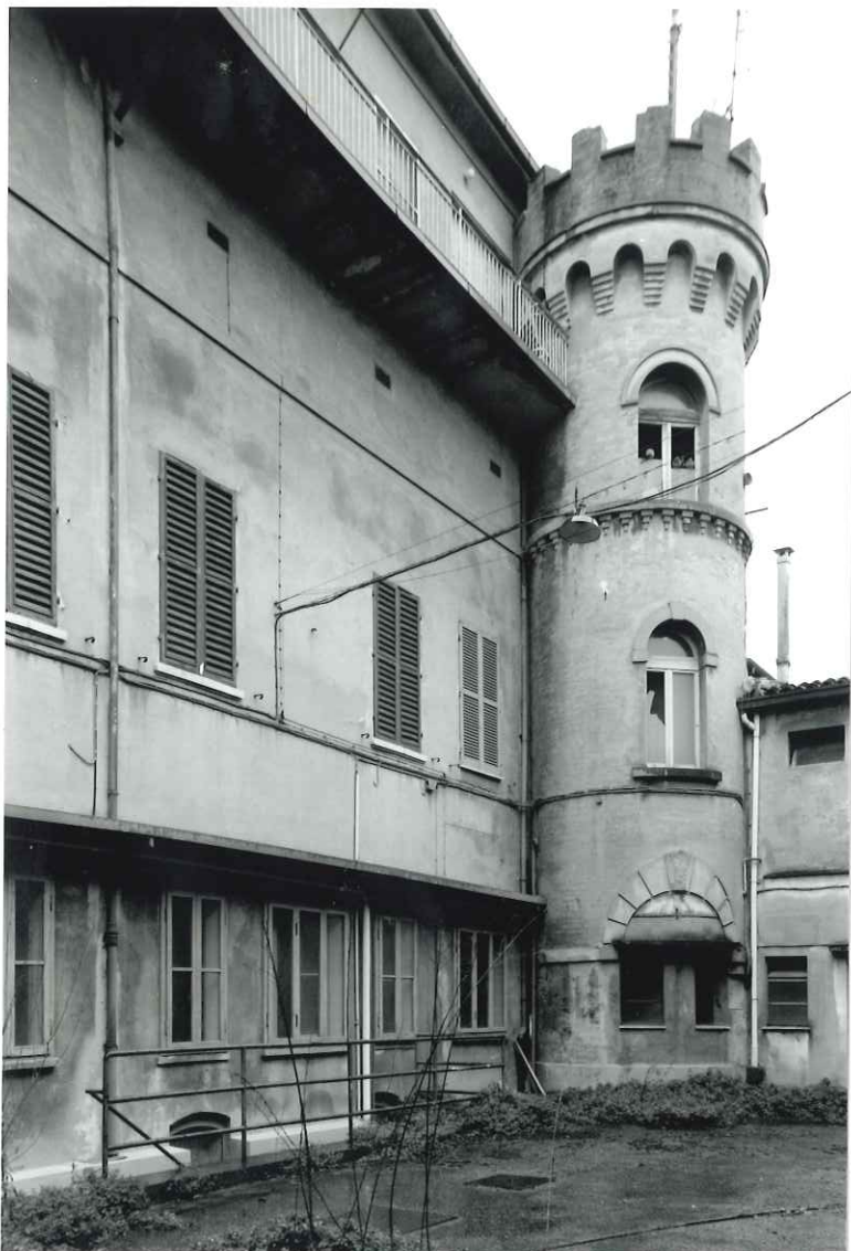
Prospetto della torre sul lato 118433
