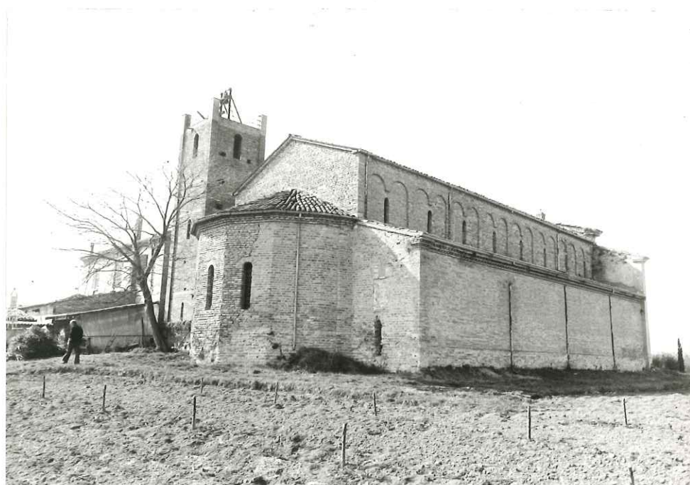
FIANCO SINISTRO E ABSIDE 57086
