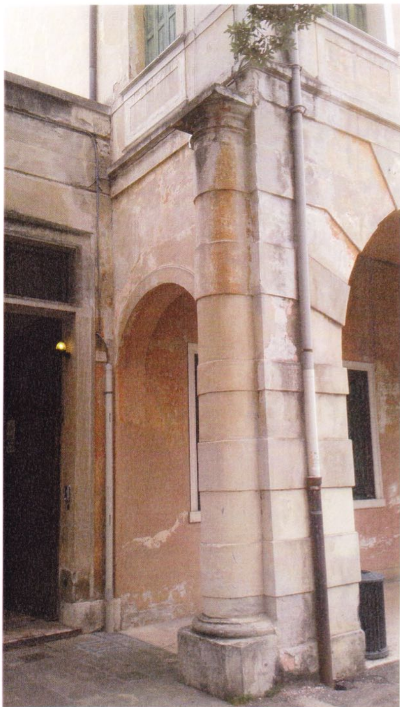
Denominazione Bene PALAZZO ANCILOTTO Comune TREVISO Didascalia dettaglio pilastro d'angolo.
