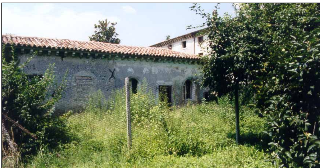
Prospetto sud-est della barchessa est della casa dei Fioretti (neg. n°67991).
