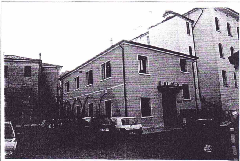
Il corpo di fabbrica relativo all' "ex Prisma". La facciata con evidenziati gli archi, prospetta sul cortile.
