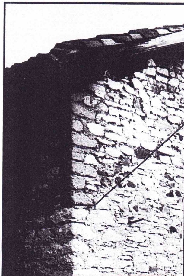
Foto 3 sotto: angolata dove risulta evidente la sopraelevazione ed il cambio di pendenza delle falde del tetto.
