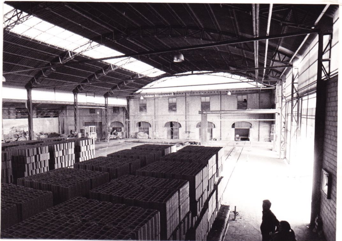
FORNACE BAGMIN INTERNO DELLO STABILIMENTO
