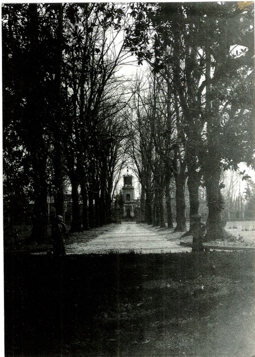
Allegato n.5 - Il viale dei tigli concluso dalla torre dell'orologio
