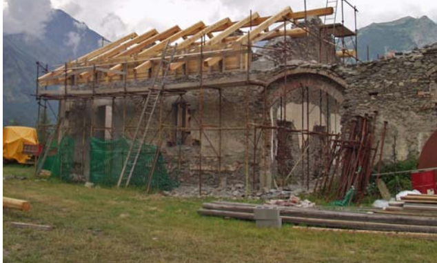
2002 - Il cantiere della prima e seconda campata
