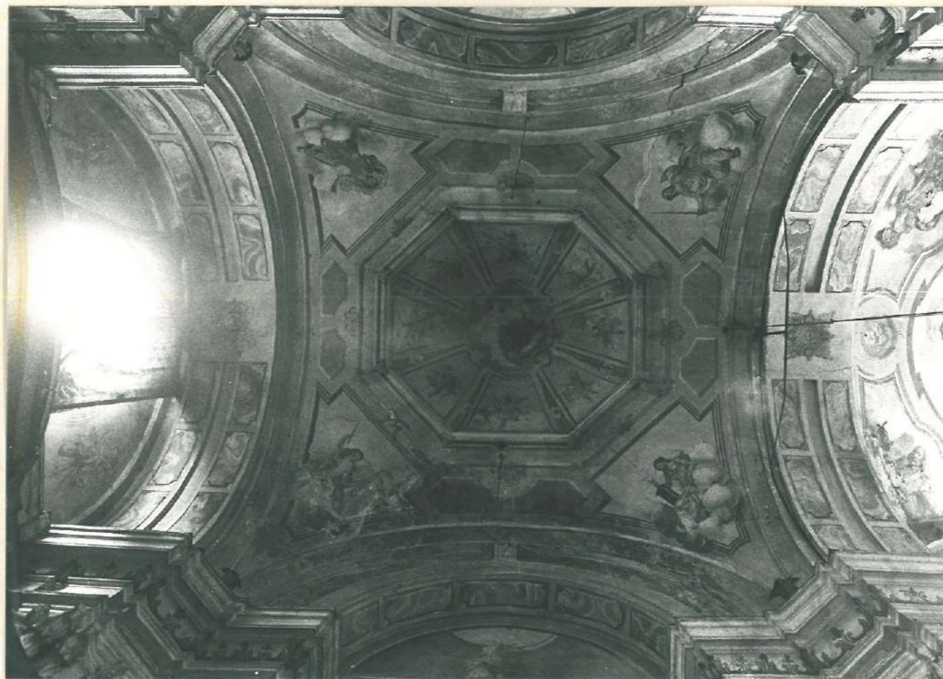
La volta del vano principale
