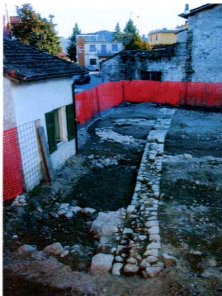
1. Il muro di difesa US 11 e la torre US 27 (da nord)
