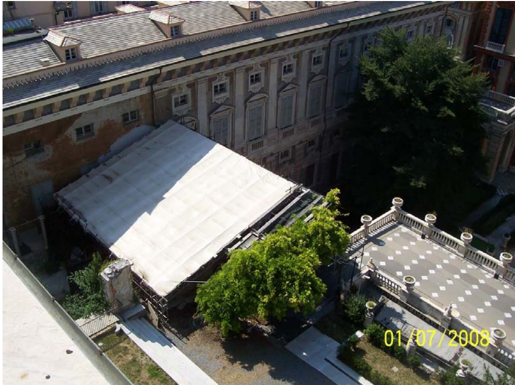
2.5. FOTO 5 : Vista dell'attuale copertura provvisoria sopra gli scavi archeologici in corrispondenza del previsto volume esterno "CERNIERA".
