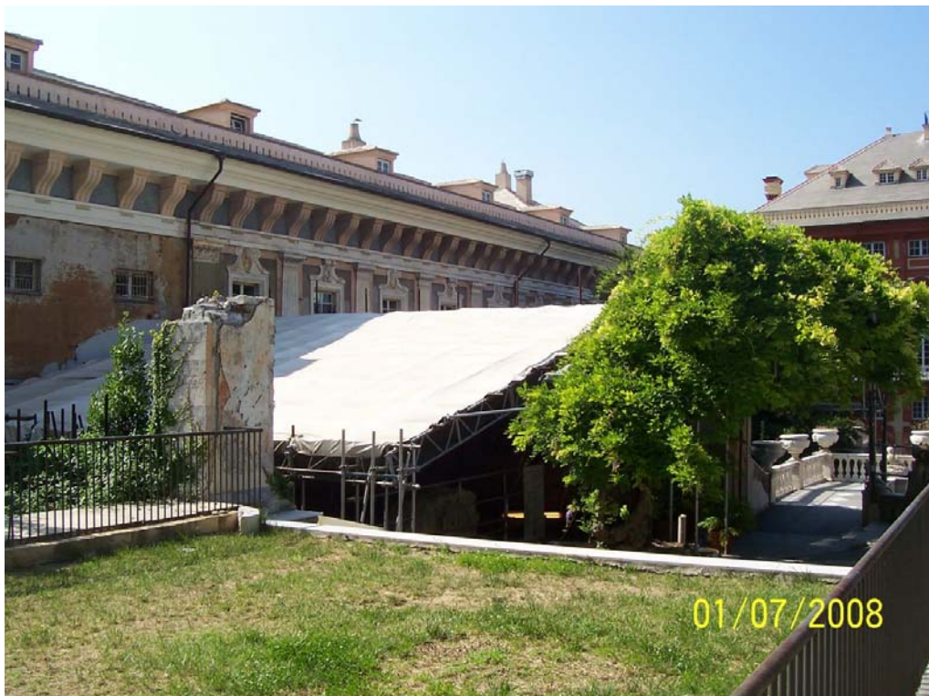
2.6. FOTO 6 : Dettaglio della copertura provvisoria in corrispondenza del previsto volume esterno "CERNIERA".
