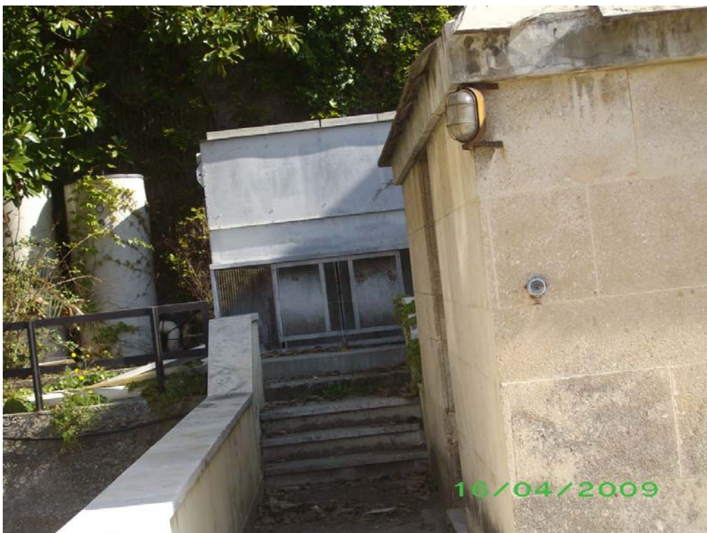
2.16. FOTO 16 : Copertura dell'atrio di Palazzo Albini In adiacenza allo sbarco della nuova piattaforma elevatrice
