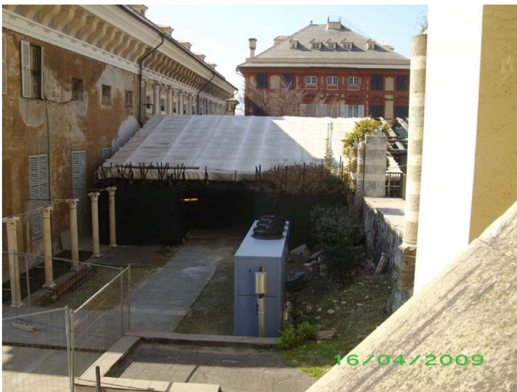
2.18. FOTO 18 : Area fra Fronte Est di palazzo Tursi e Palazzo Galliera futura sede della nuova rampa ad "L" ora occupata dal chiller di cui si prevede la ricollocazione.
