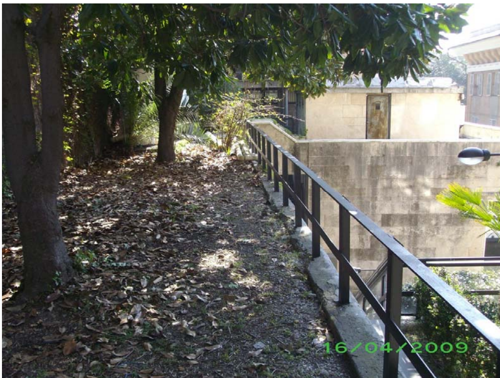
2.17. FOTO 17 : Vista delle scale di accesso a Palazzo Galliera Sullo sfondo la sede ove sarà installato il nuovo elevatore
