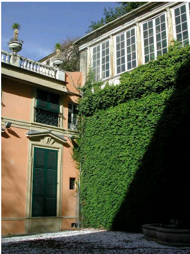
2.2. FOTO 2 : Dettaglio del Prospetto SUD della “CERNIERA”
