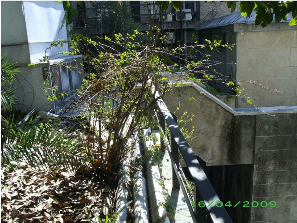
2.15. FOTO 15 : Vista del giardino terrazzato sede del nuovo collegamento
