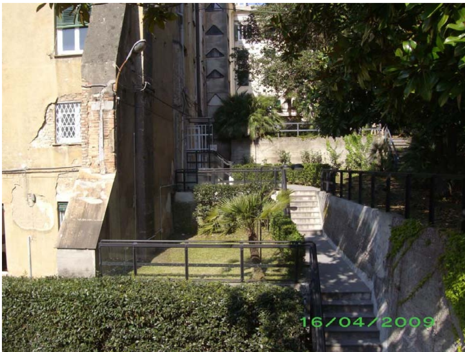
2.14. FOTO 14 : Attuale accesso a Palazzo GALLIERA Piano Primo.
