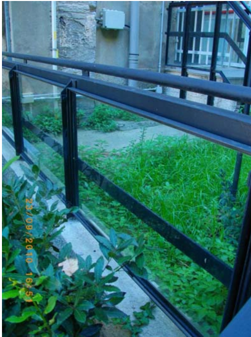
FOTO 15- 16 : Retro Palazzo “Galliera” (Interventi B2) – Ringhiera Tipologia tamponamento vetrato
