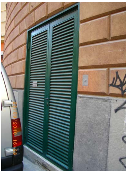
FOTO 17 : Porta Cabina ENEL in Piazza della Meridiana
