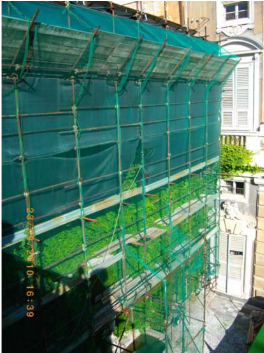
FOTO 1 - 2 : "CERNIERA" (Intervento C) – Impalcature e ponteggi struttura provvisoria
