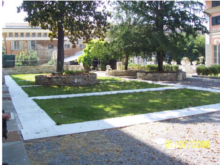
FOTO 3 : Giardino Evocativo (Intervento C2) – Lastre in marmo a delimitare le aree a verde e ghiaio
