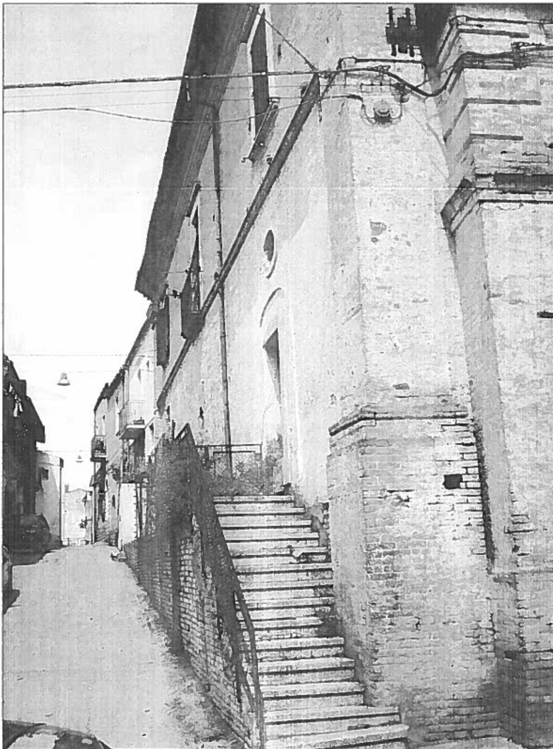
11) Via G. Mazzini prospetto sud, ingresso all'ambulatorio medico. Al piano interrato sotto al poggiolo è ricavata la legnaia.
