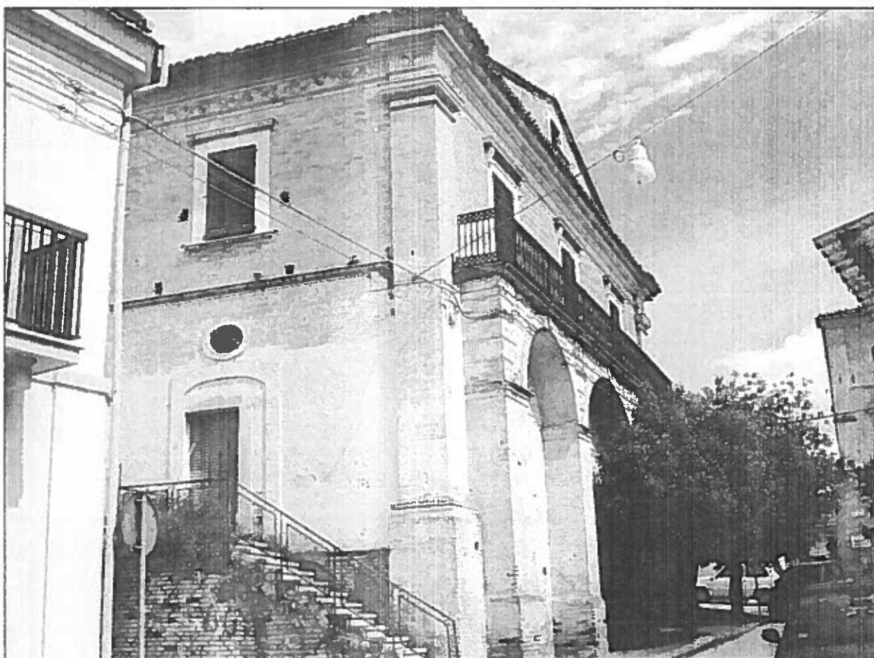
10) Da via Papa Giovanni XXIII, angolo via G. Mazzini, ingresso all'ambulatorio medico. Gradini in cemento granigliato levigato e balaustra in ferro dell'inizio del XX secolo.
