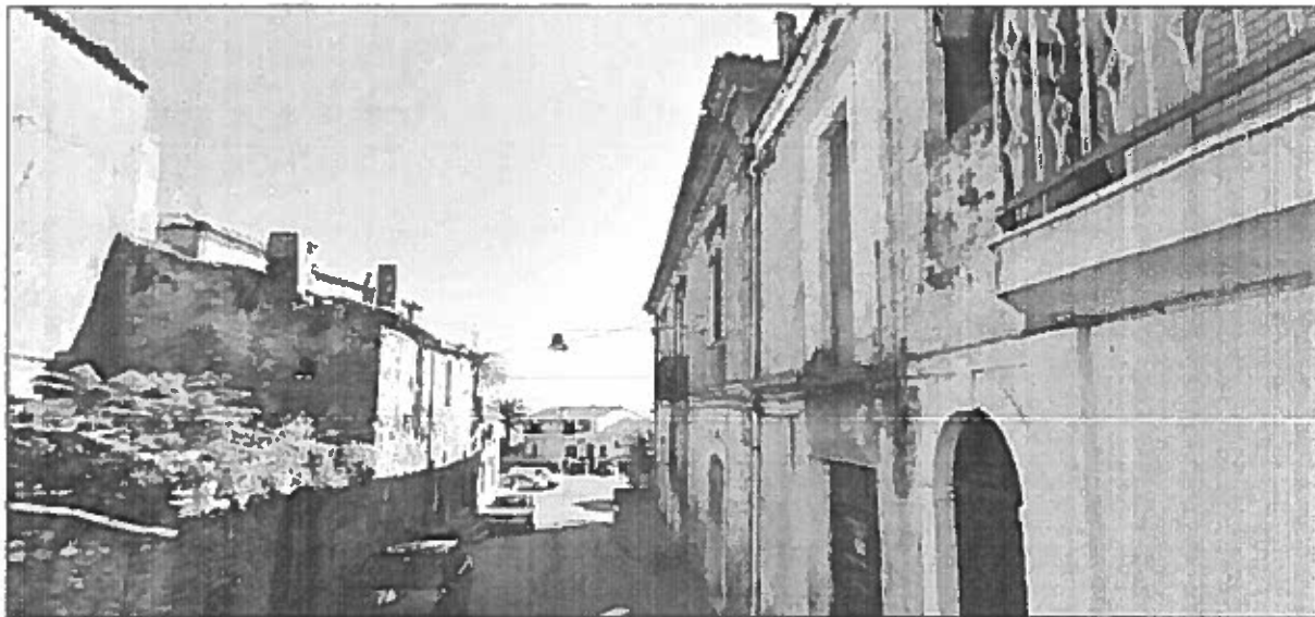
13) Vista del prospetto nord su via G. Matteotti (già via 23 Marzo).
