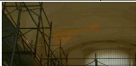
**PUNTELLAMENTO A SOSTEGNO DELLA VOLTA**
