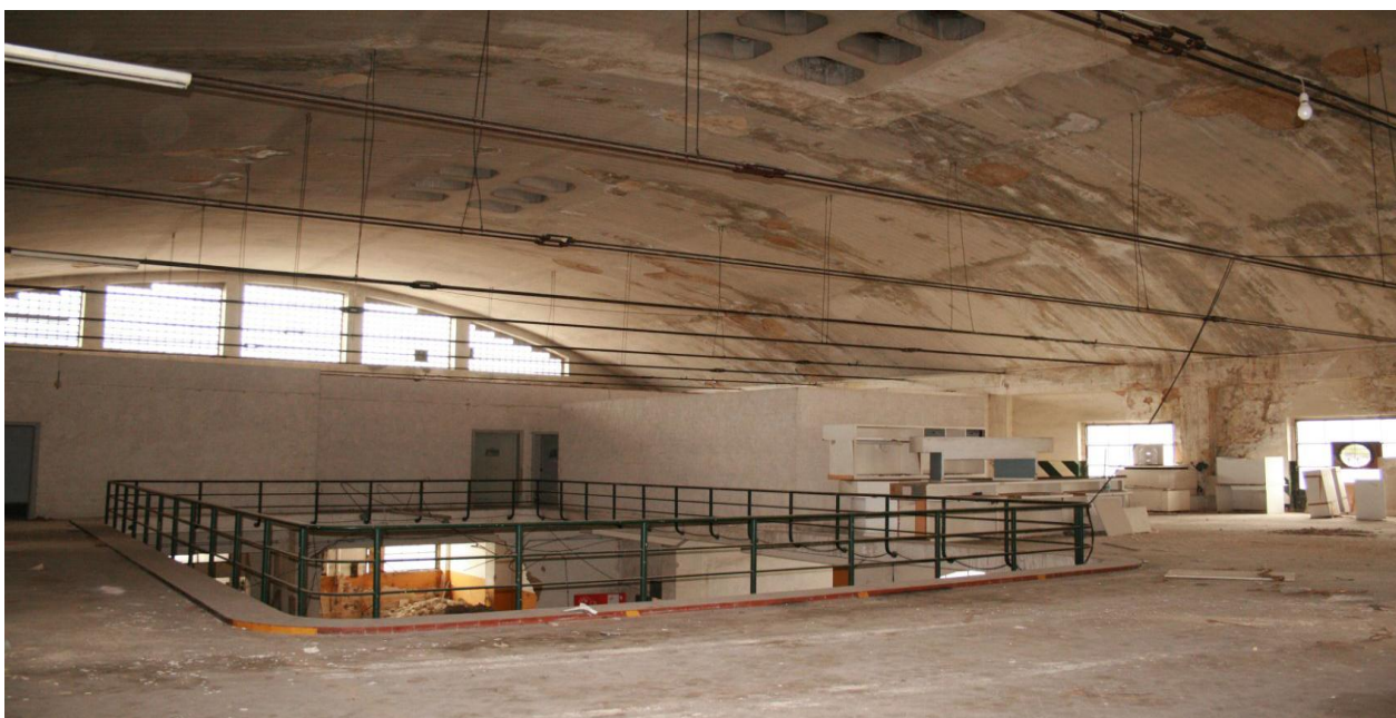
Particolare della volta "tirantata"
