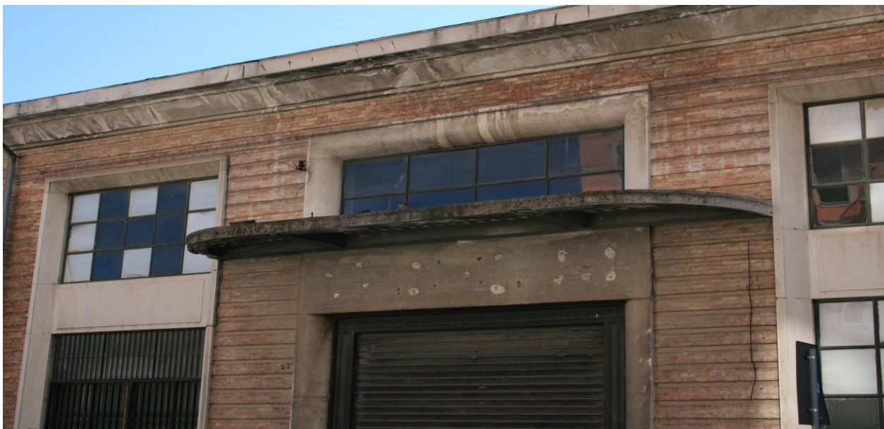
PARTICOLARE DEL LATO NORD Pensilina in vetro cemento
